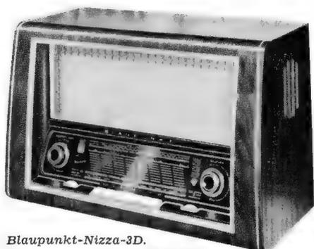
**Blaupunkt-Nizza-3D.** Auf der Vorderseite befindet sich ein permanentdynamischer Lautsprecher (16 x 18 cm), aus den Schlitzen in den Seitenwänden strahlt je ein Kristall-Lautsprecher mit 10 cm Durchmesser. 6/9-Kreise, 319.- DM
