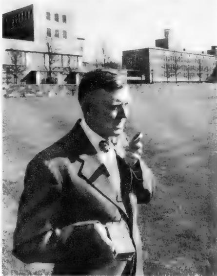
Bild 2. Ing. D.E. Thomas von den Bell-Laboratorien in Murray Hill, N.J. hält eine der neuen Sonnenbatterien in das helle Licht der Mittagssonne. Sie dient als Energiequelle für einen transistorbestückten Kleinstsender in der Brusttasche des Jacketts. Mit dieser Anlage kann Mr. Thomas über mehrere Kilometer hinweg funksprechen
